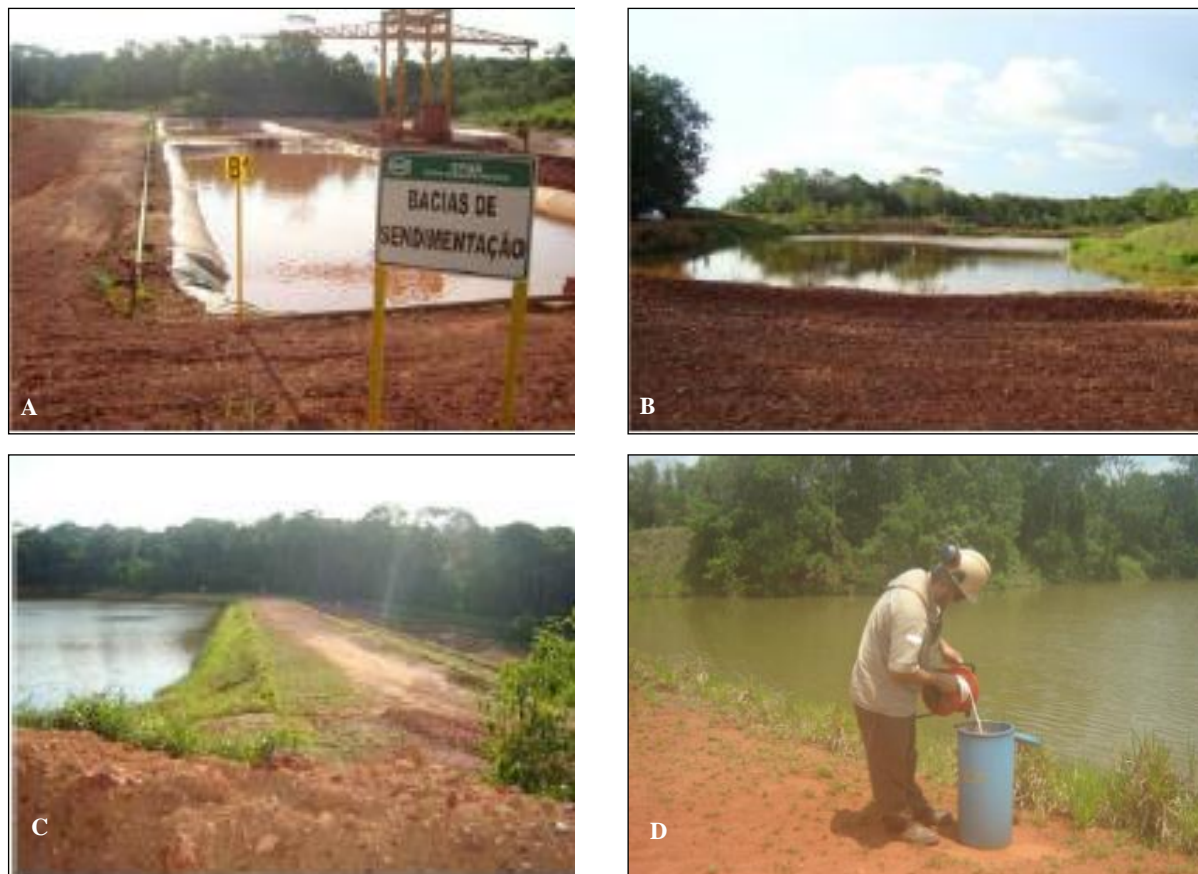
Figura 45 – Registros fotográficos das bacias de sedimentação e da Barragem A1. Na Foto A, a bacia de sedimentação B1, na Foto B, a bacia de sedimentação B5, na Foto C, a Barragem A e na Foto D, monitoramento piezométrico na Barragem A1.
