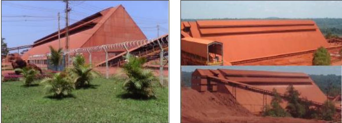
Figura 5.3-33. Vista geral do depósito de estocagem de produto seco.
