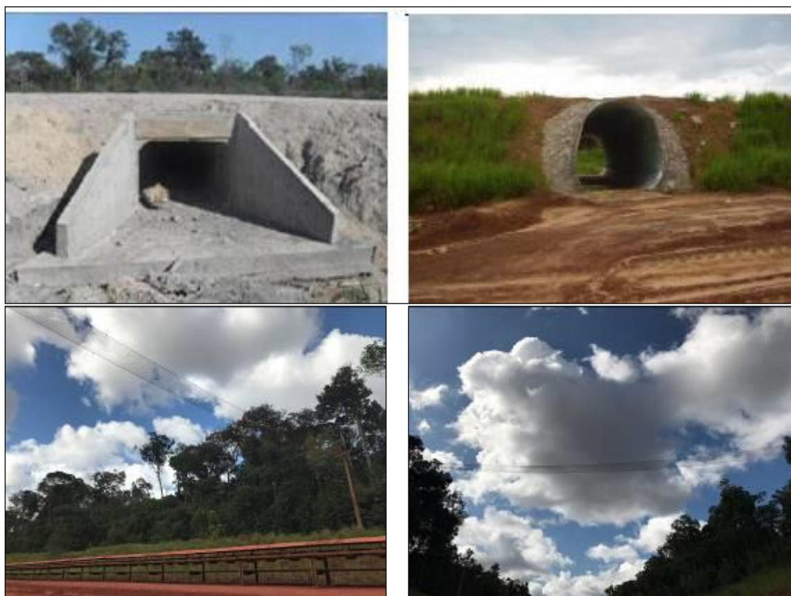
Figura 56 – Exemplos de estruturas e dispositivos de passagem de fauna silvestre (túneis e passagens aéreas) já adotados pela MRN em suas instalações preexistentes.
