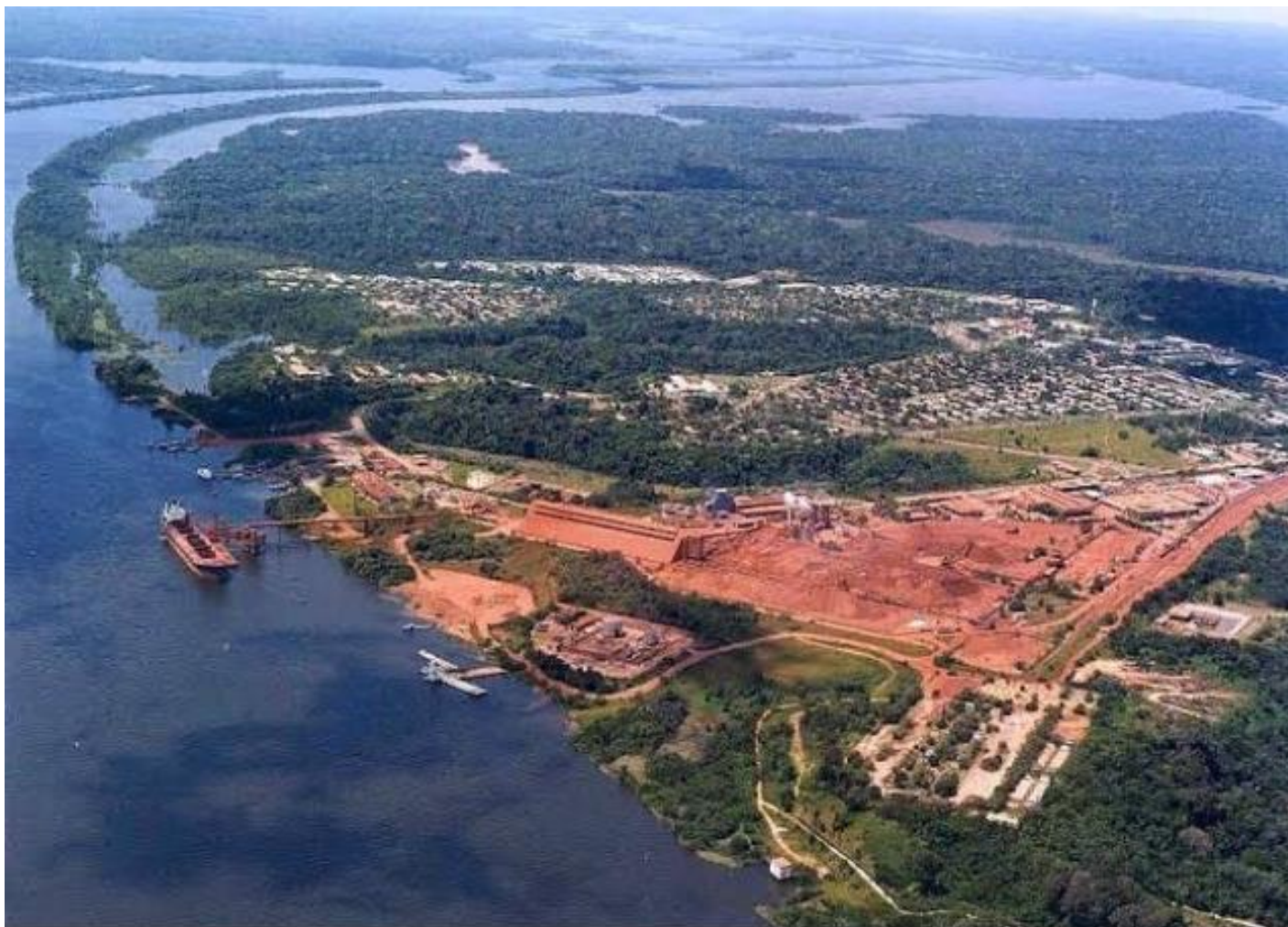
Figura 31 – Vista geral da área do porto.
