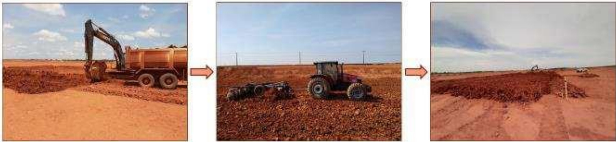
Figura 5.3-71. Ciclo de remoção – 1ª remoção, preparação com gradeamento e 2ª remoção.
