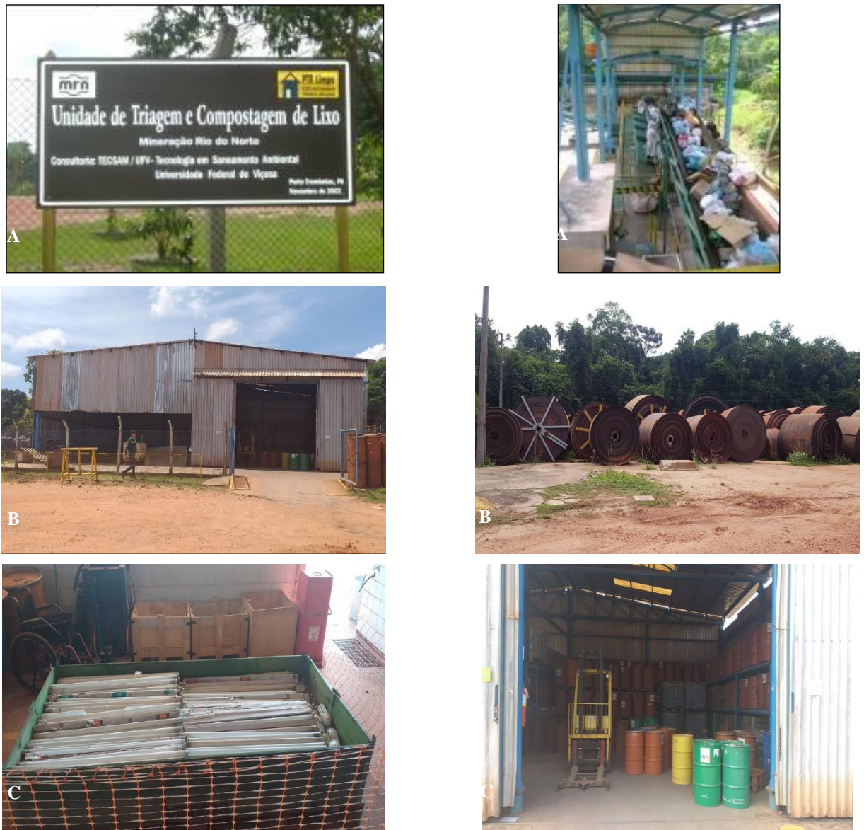
Figura 58 – Instalações de gestão de resíduos sólidos. Registro da Unidade de Triagem e Compostagem (A); da Área de Armazenamento de Resíduos (Porto) (B) e da Área de Armazenamento de Resíduos (Mina) (C).
