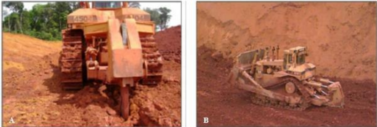
Figura 5.3-16. Equipamentos realizando o desmonte mecânico do minério, dentro das operações de lavra propriamente dita.
