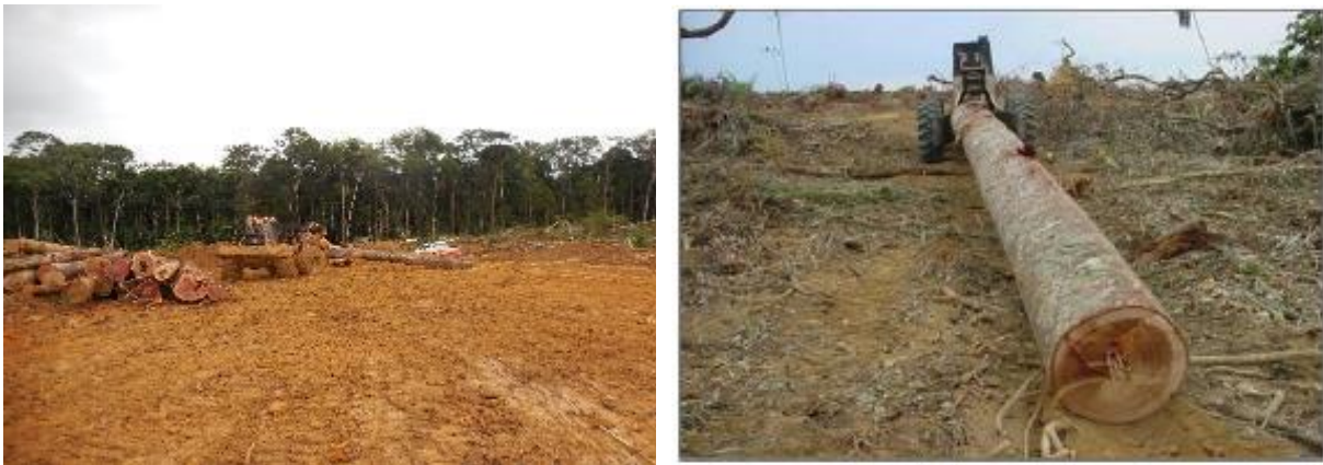
Figura 5.3-11. Registro da operação de arraste da madeira com trator florestal.
