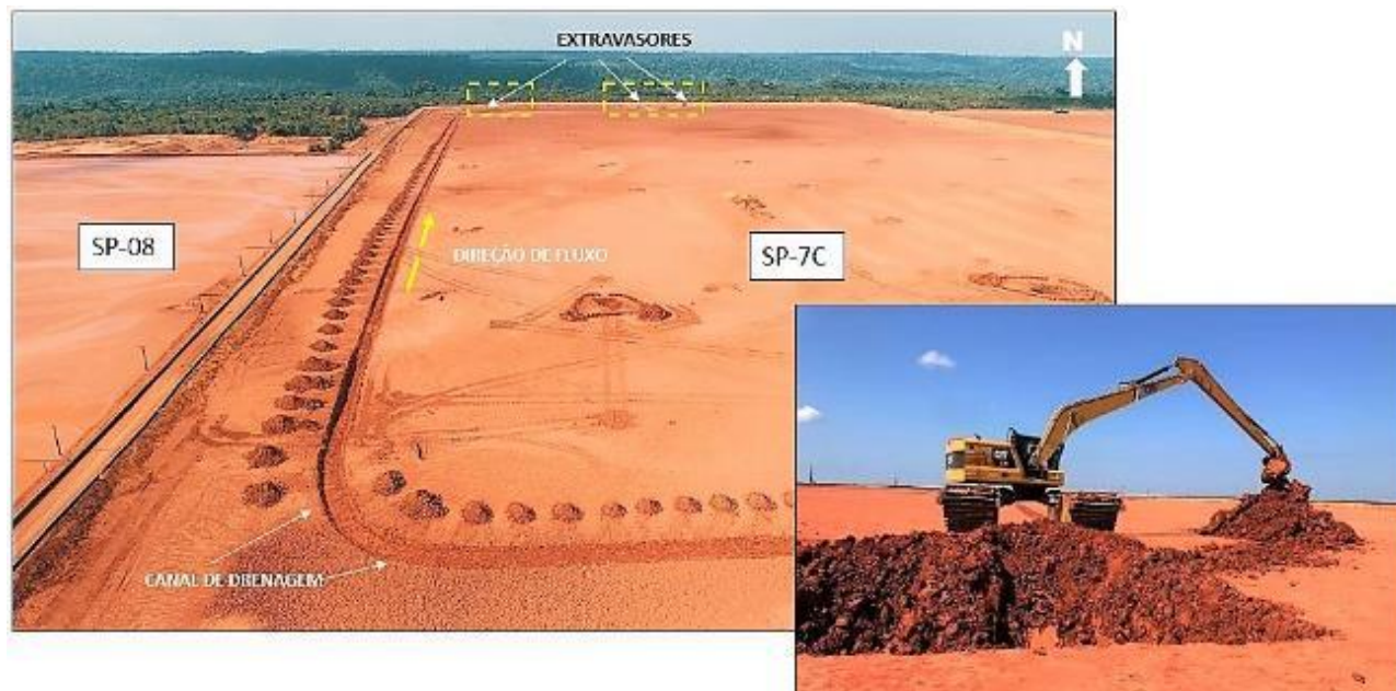
Figura 108 – Sistema de canais de drenagem para manejo de água e escavadeira anfíbia em operação
