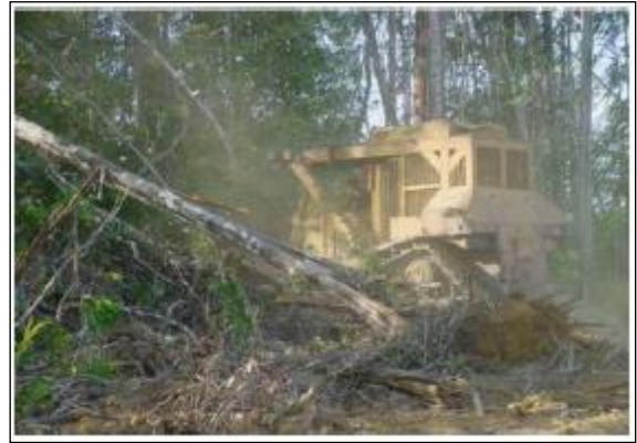
Figura 7 – Registro da operação de supressão vegetal com emprego de trator de esteiras do tipo CAT - D11.
