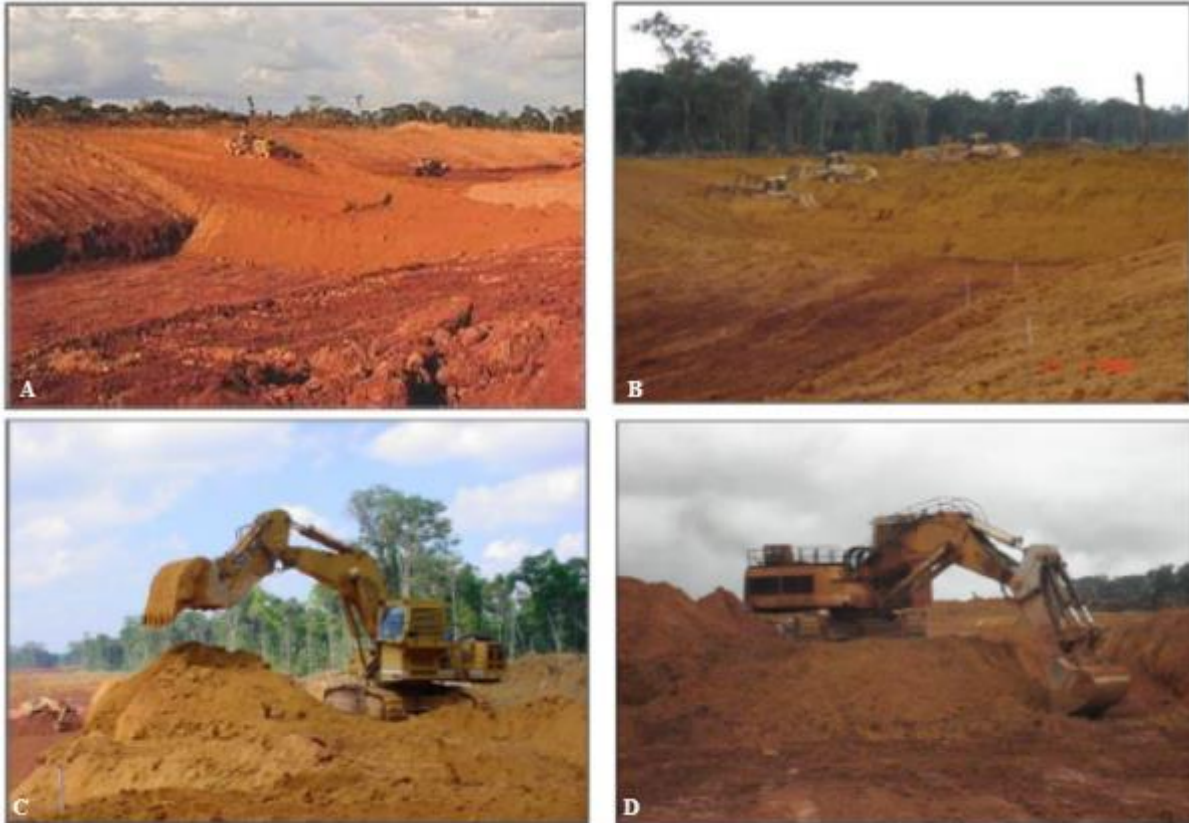
Figura 5.3-15. Registro de Operações de decapeamento. A e B) Registro da operação de decapeamento realizada com trator de esteira; C e D) Registro da operação de decapeamento realizada com escavadeiras.
