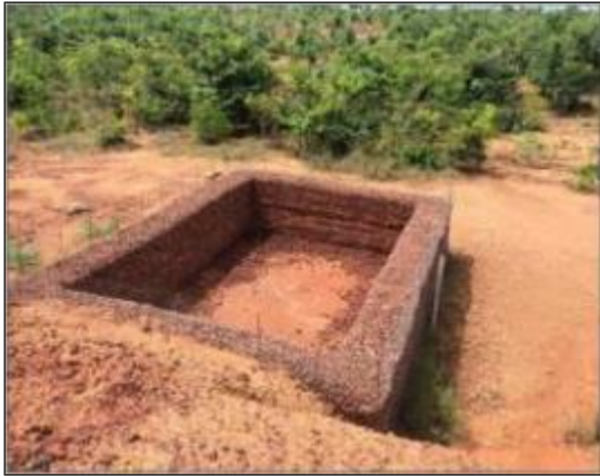
Figura 5.3-110. Dreno de Borda implantado na Mina Bela Cruz.
