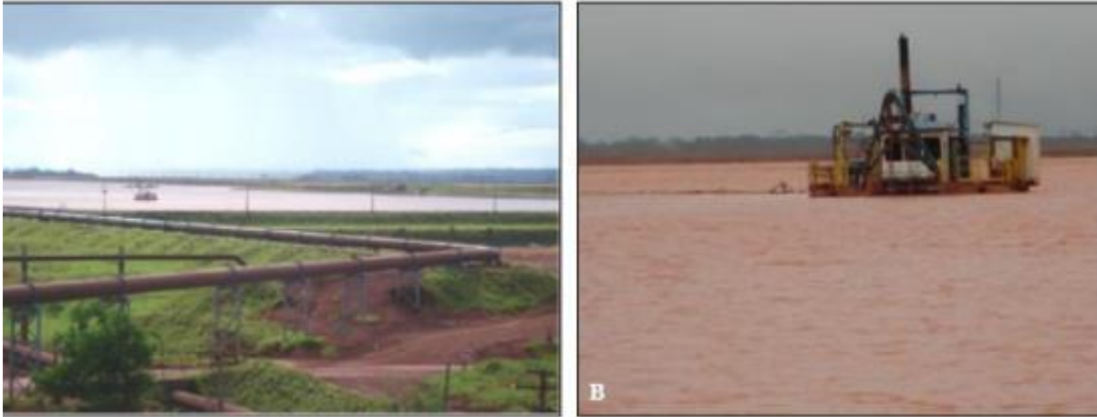
Figura 5.3-24. Tanque de Rejeitos TP2 e Dragas.
