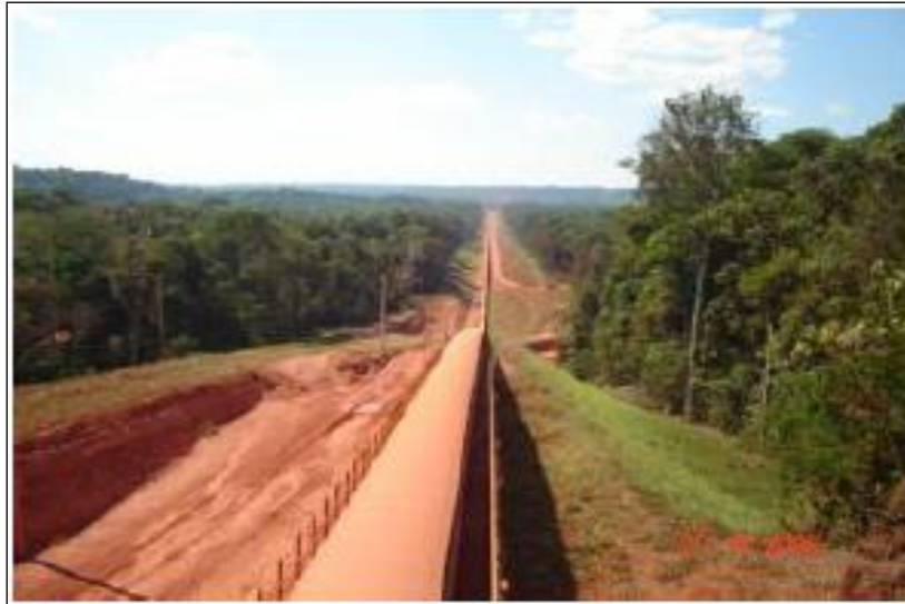
Figura 5.3-20. Transporte de minério através de correias transportadoras de longa distância (TCLD)
