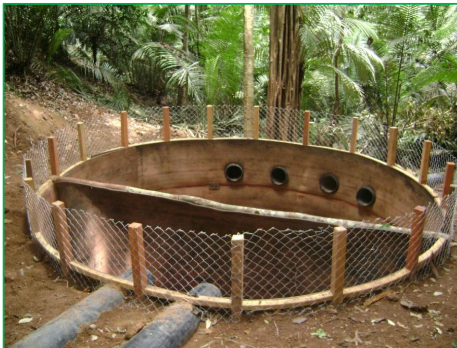
Figura 4 - Modelo de caixa dissipadora (Girau)
