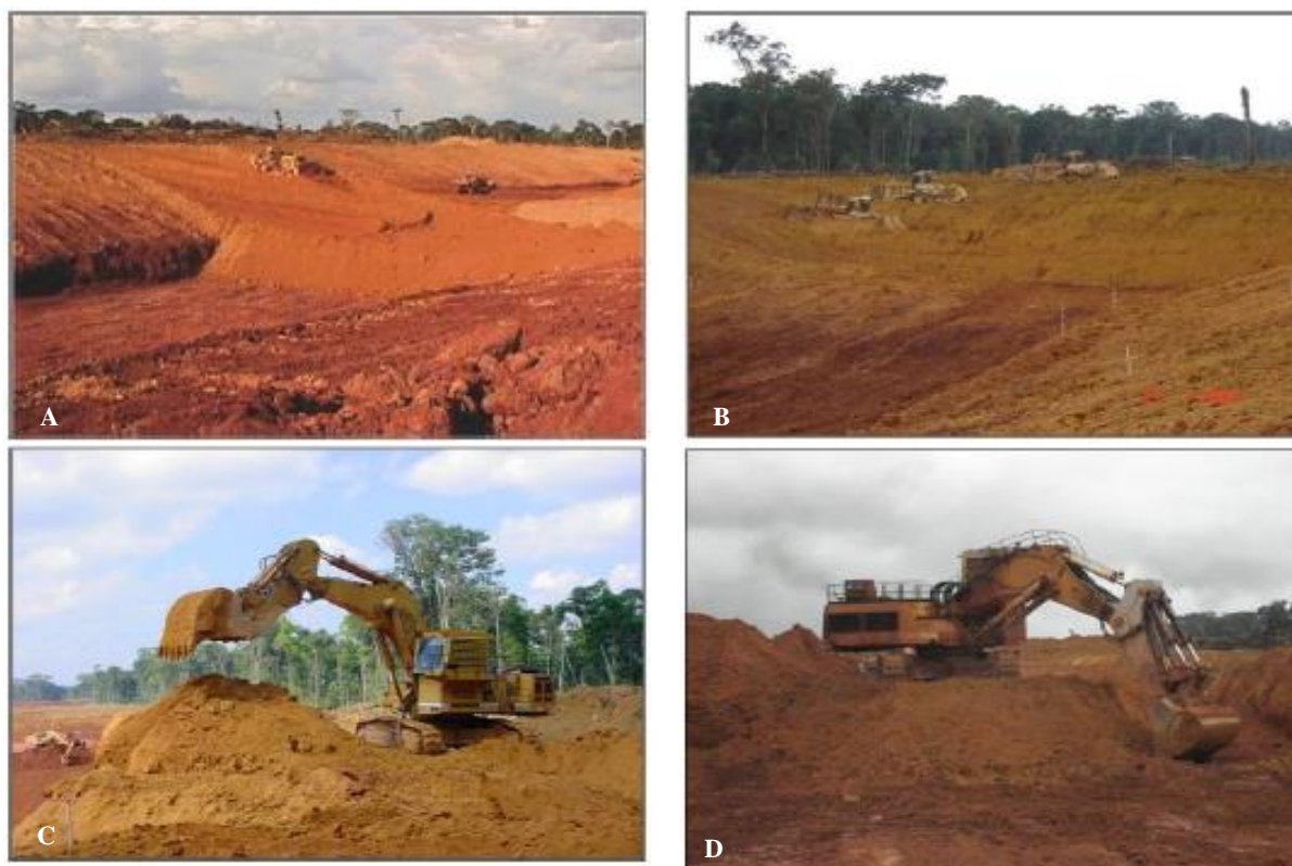
Figura 12 – Registro da operações de decapeamento.
