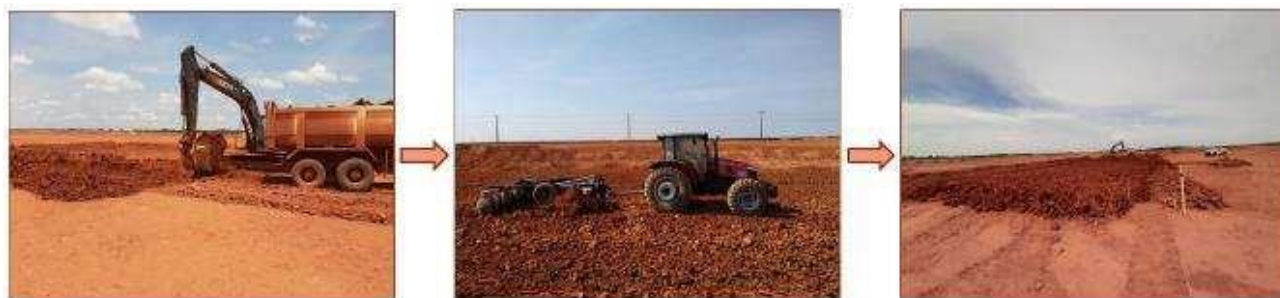
Figura 102 – Ciclo de remoção – 1ª remoção, preparação com gradeamento e 2ª remoção
