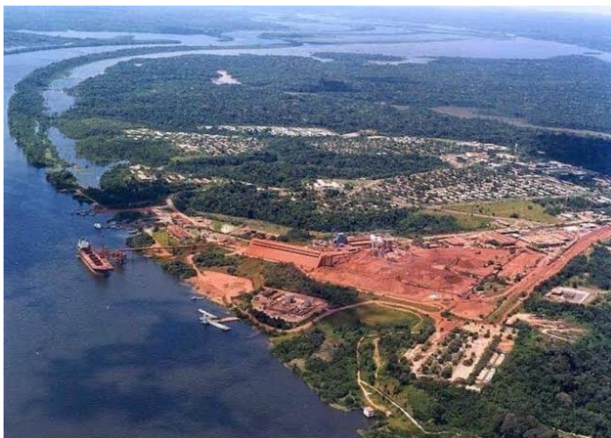
Figura 5.3-35. Vista geral da área do porto.
