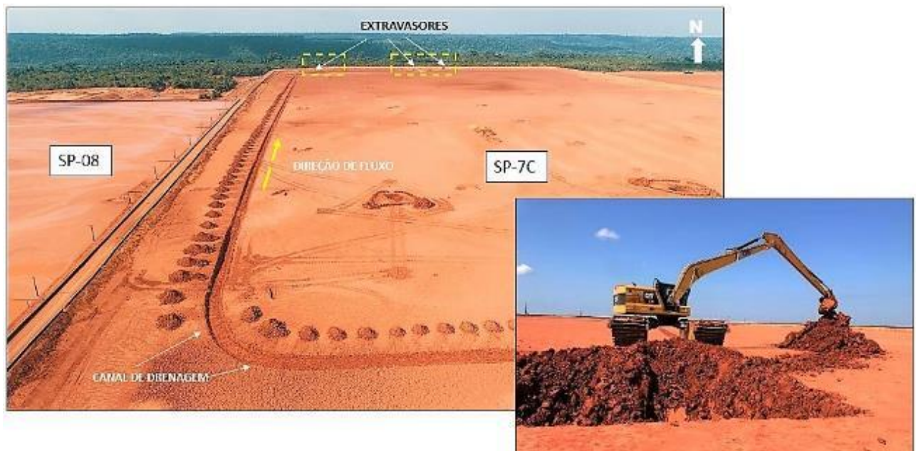
Figura 49 - Sistema de canais de drenagem para manejo de água e escavadeira anfíbia em operação
