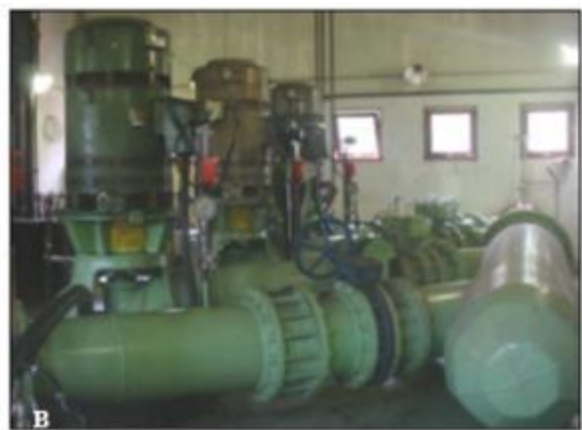
Figura 5.3-100. Captação de água do rio Trombetas. A) Prédio que abriga as instalações. B) conjuntos motobombas.
