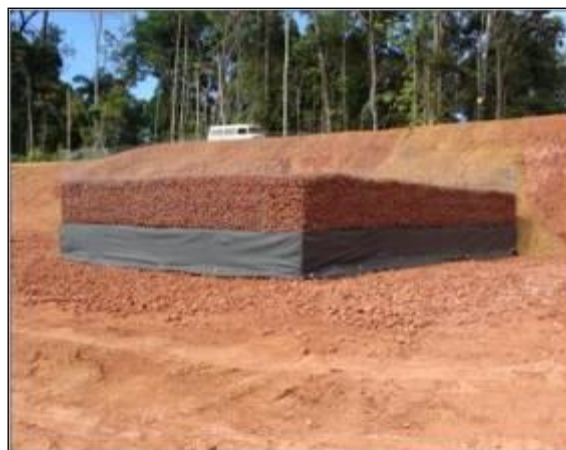
Figura 41 – Dreno de Borda implantado na Mina Bela Cruz.
