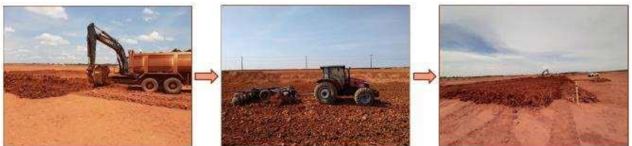
Figura 43 - Ciclo de remoção – 1ª remoção, preparação com gradeamento e 2ª remoção
