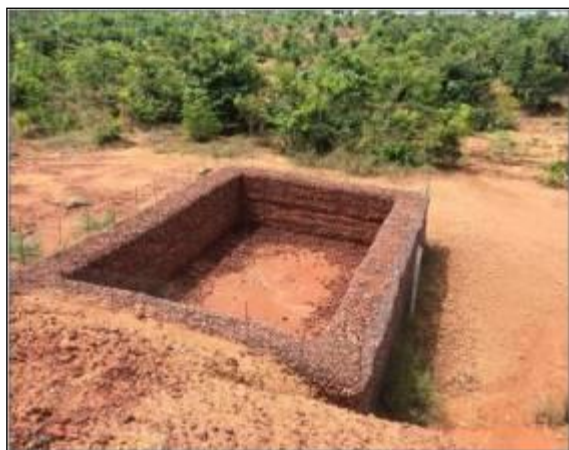
Figura 41 – Dreno de Borda implantado na Mina Bela Cruz.
