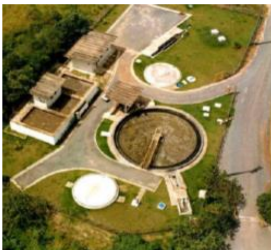
Figura 34 – Vista geral da ETE da Vila de Porto Trombetas.
