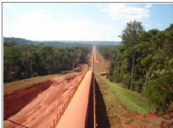
Figura 17 – Transporte de minério através de correias transportadoras de longa distância (TCLD).
