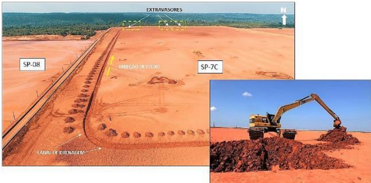
Figura 5.3-73. Sistema de canais de drenagem para manejo de água e escavadeira anfíbia em operação
