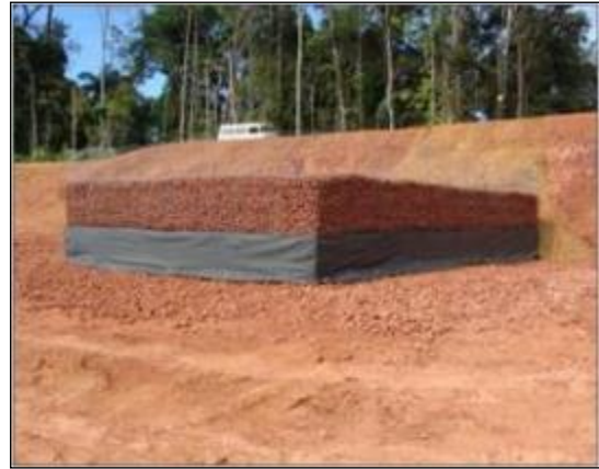
Figura 5.3-110. Dreno de Borda implantado na Mina Bela Cruz.
