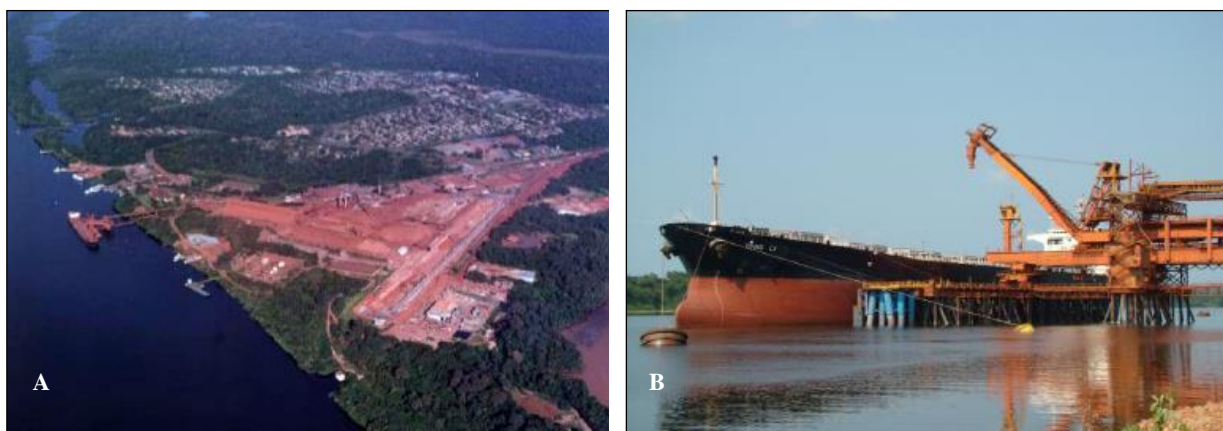
Figura 30 – Registro geral da área portuária (A) e da operação de carregamento do navio através de shiploader (B).
