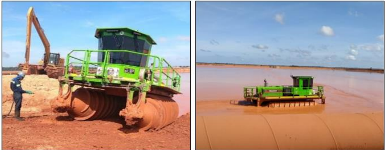
Figura 5.2-12 – “ Mud Farming ” em operação no SP-13, TSF-MRN (Nov/20).
