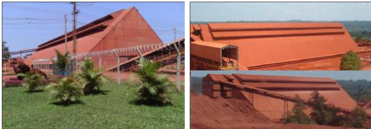
Figura 29 – Vista geral do depósito de estocagem de produto seco.
